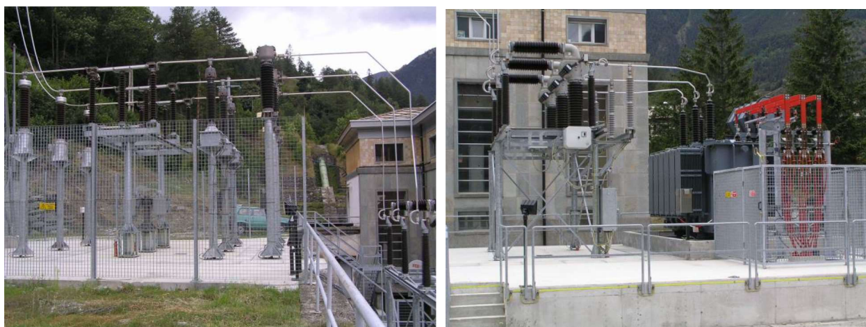
Figura 15 - Montante linea 132 kV (a sin) e montante trasformatore TR1 - TR2 132 kV (a dx).
