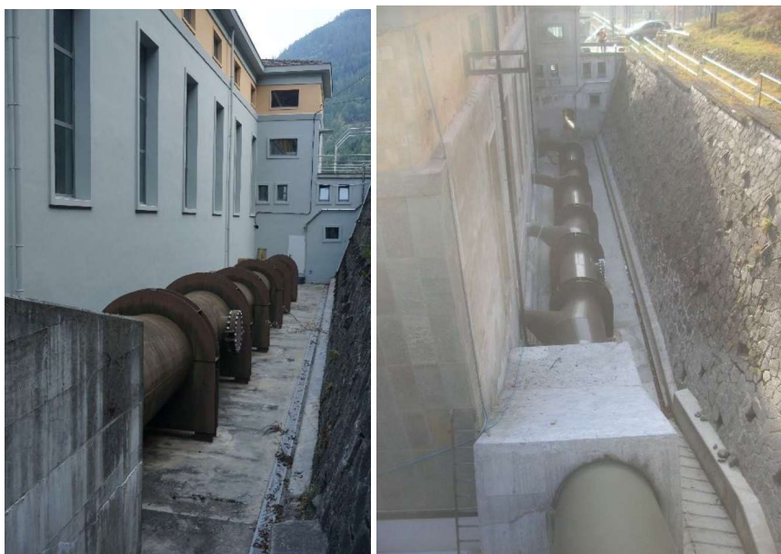
Foto 7 - Il nuovo collettore in centrale.
