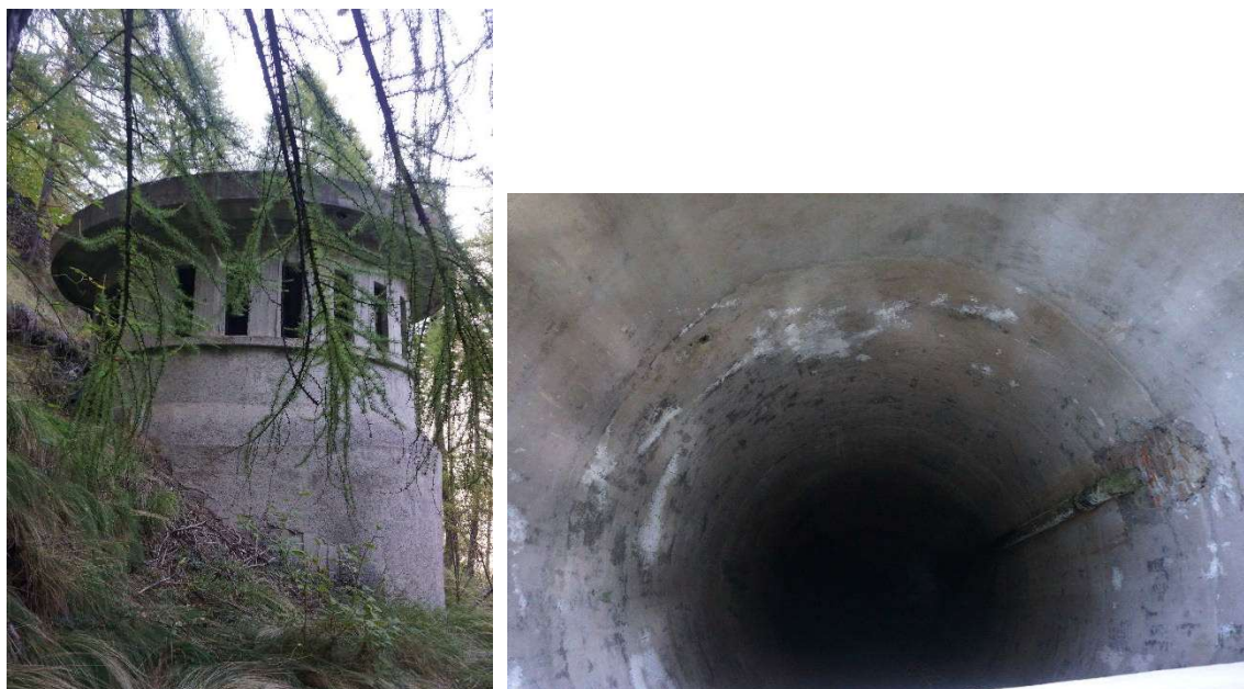
Foto 4 - Esterno e interno del pozzo piezometrico.
